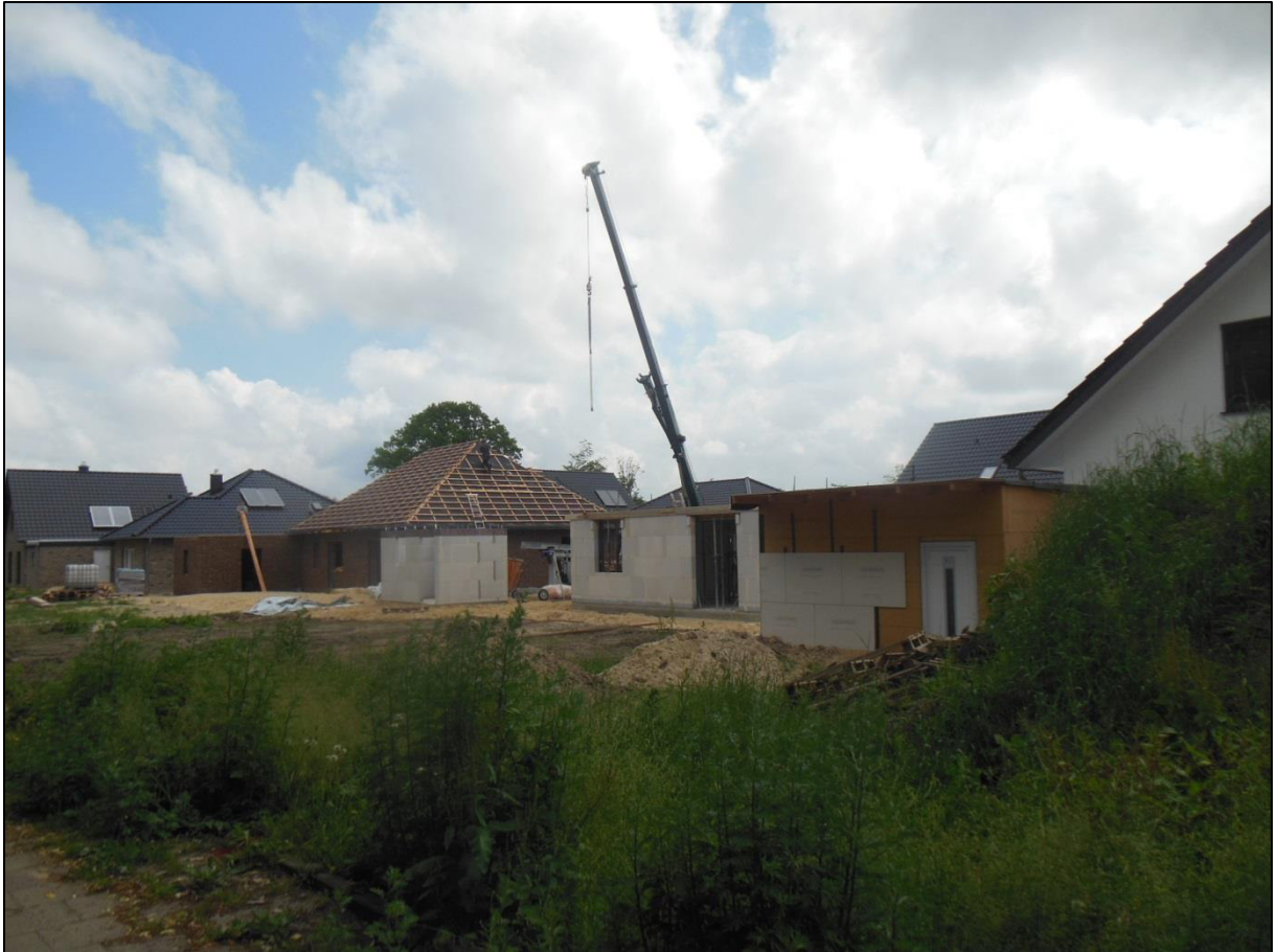
Foto: Es wird fleißig gebaut. Hier entsteht das neue Waldviertel in Leherheide-West.
